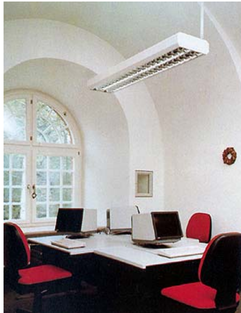
6.4. ábra. Irodavilágítás direkt-indirekt lámpatestekkel
